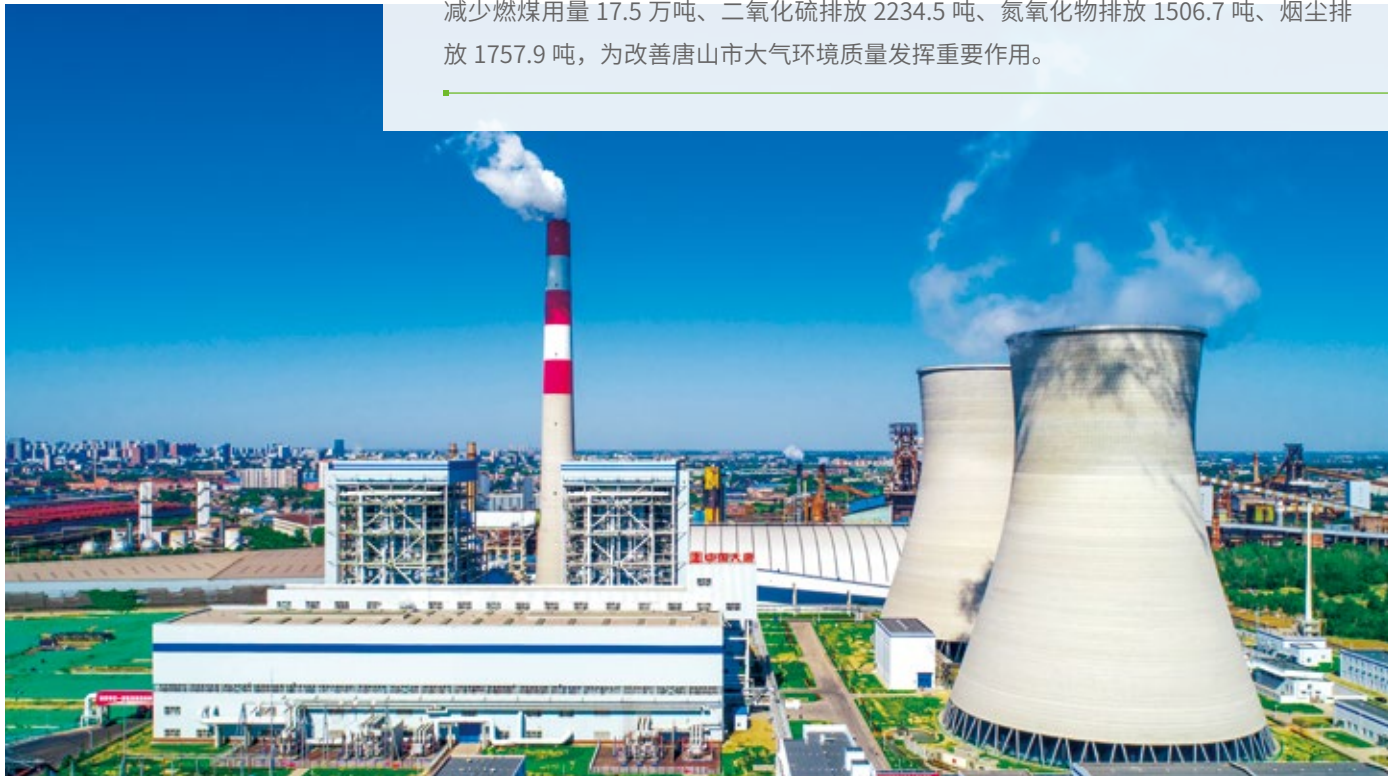
▲ 河北大唐国际唐山北郊热电公司超临界热电联产机组建成投产
