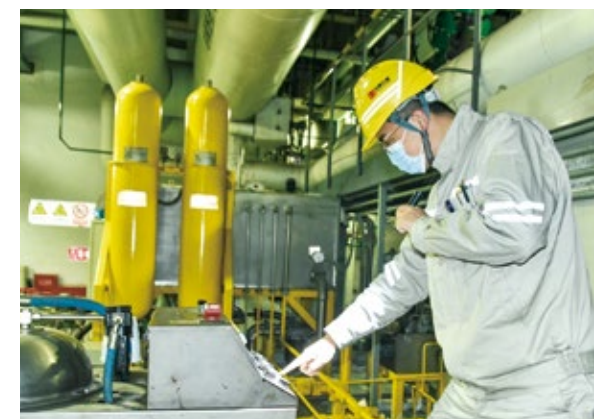
大唐浙江分公司检修人员认真检查设备
