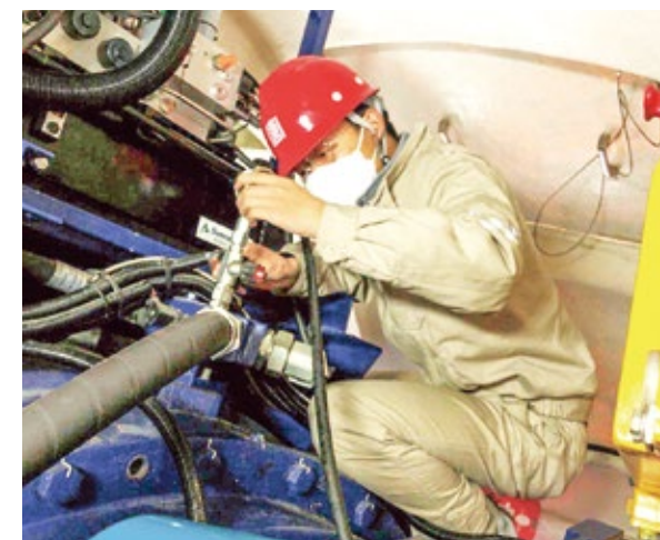
大唐湖北能源开发公司常风电场员工在风机机舱内进行维修
