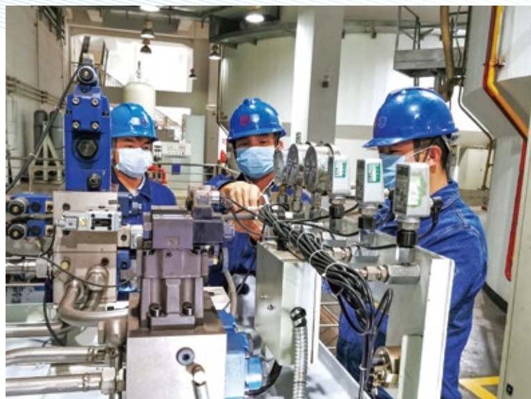
▶ 大唐缅甸太平江水电站员工全神贯注投入工作
