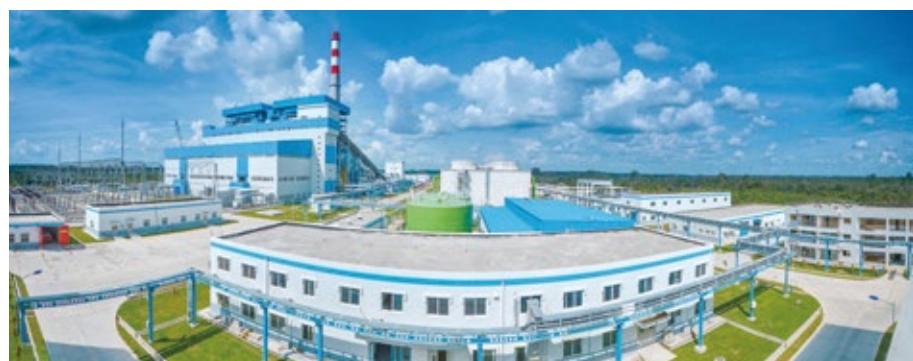
▲ 印尼大唐金光电力有限公司苏姆赛电厂
