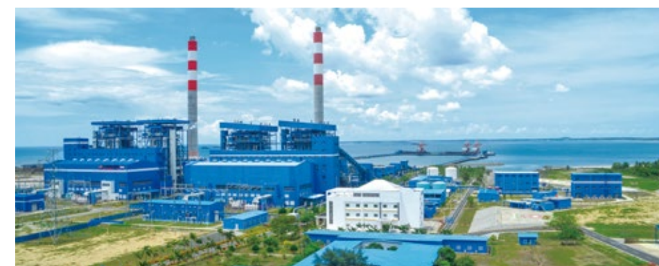
▲ 中国大唐承揽的印尼吉利普多2台13.5万千瓦燃煤机组的运行、维护、检修工作，受到印尼国家电力公司和印尼业主的高度肯定
