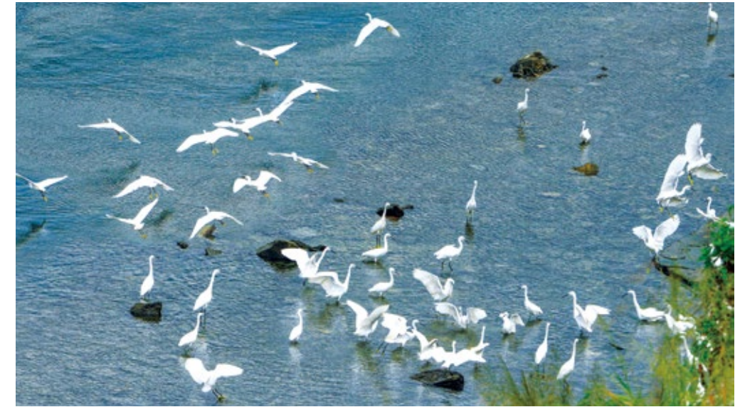
▲ 大唐龙滩水电站注重库区生态保护，水电站大坝下游白鹭自在飞翔
