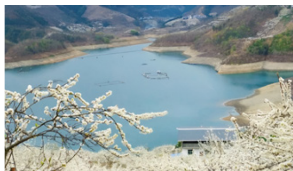
龙滩水电站2007年至2022年，水库已拦蓄洪水919亿立方米
