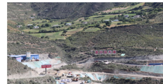
扎拉水电站施工现场
