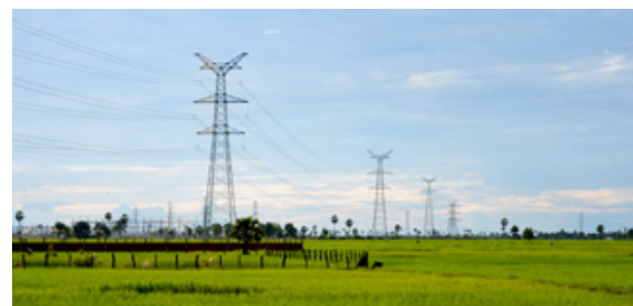
柬埔寨金边西一马德望230kV输变电项目
