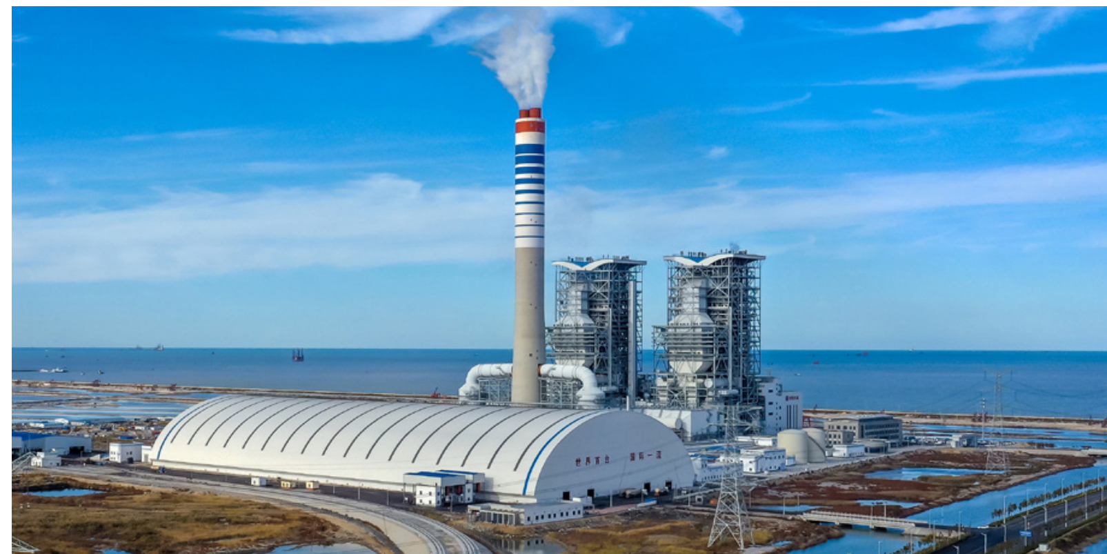
11月14日，东营发电有限公司2号机组成功应用智能启停系统完成一键启动并网，成为集团公司首个实现全过程智能启动至带负荷的百万机组
