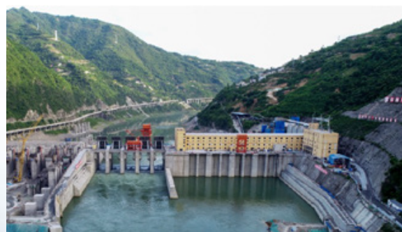
12月，旬阳水电厂四台机组通过72小时试运行，创造了陕西境内汉江流域水电机组“一月四投”的新纪录
