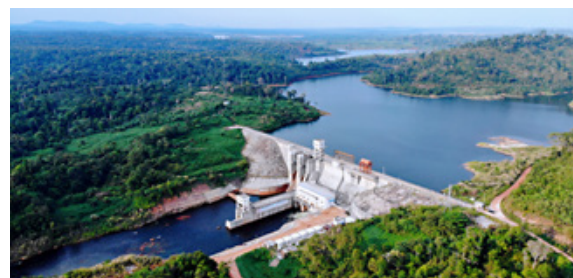
柬埔寨斯登沃代水电站项目
