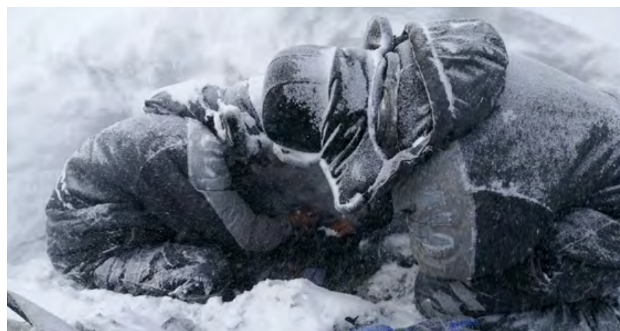
大唐国际承德新能源事业部抢修人员跪卧雪地中检查电缆接头，守护着万家灯火
