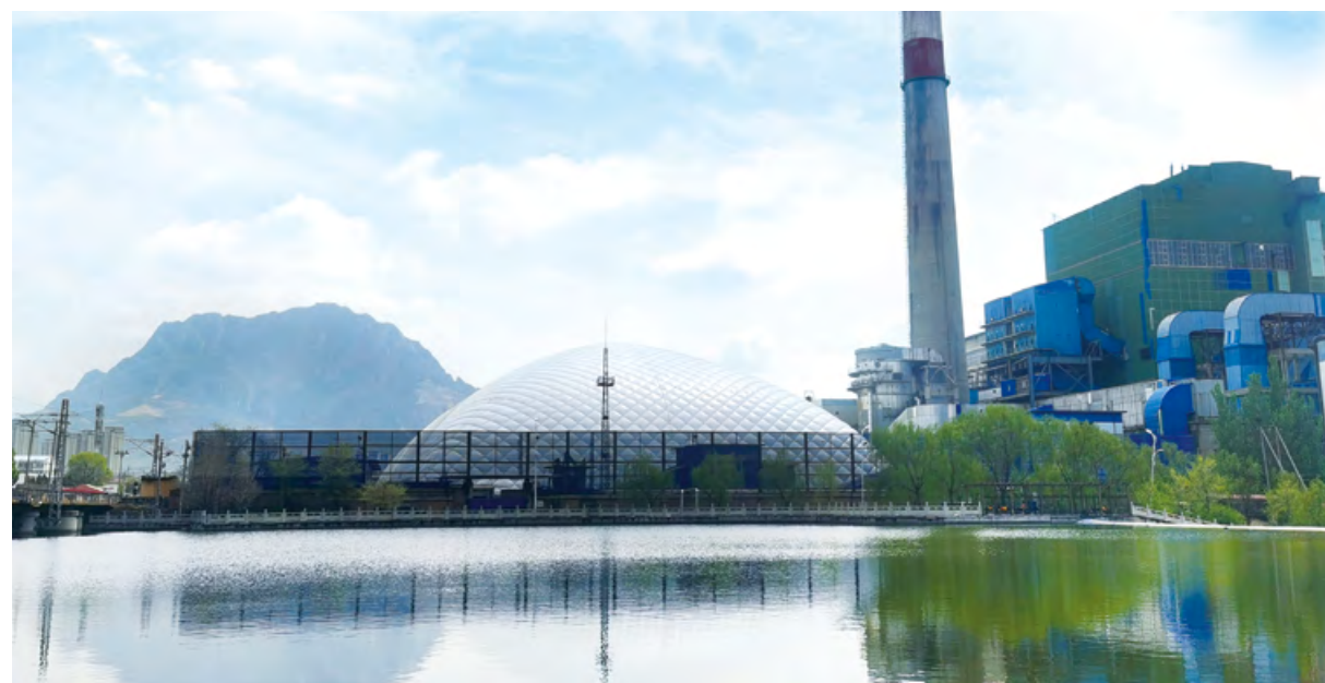
大唐国际下花园发电厂投资1300万元完成煤场封闭改造工程，该工程占地14175平方米，存煤量4.5万吨，为保冬奥会空气质量做出卓越贡献。
